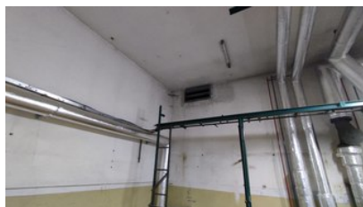
3 ilustrační foto původní kotelny, pohled směrem do dvorní části
