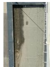
6 markýza Ondříčkova 35 -pohled na hydroizolaci
