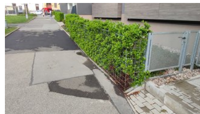
2 prostor nad původním vstupem do kotelny
