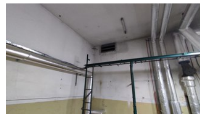
4 ilustrační foto původní kotelny, pohled směrem do dvorní části
