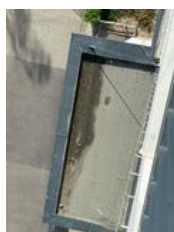
7 markýza Ondříčkova 35 -pohled na hydroizolaci
