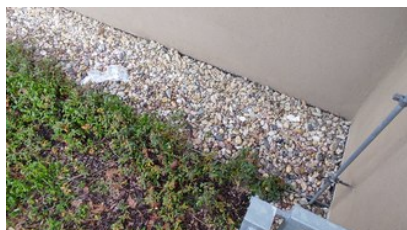
5 prostor nad původním vstupem do kotelny
