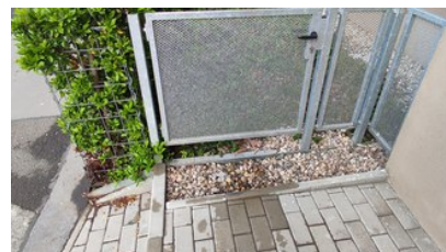
6 prostor nad původním vstupem do kotelny
